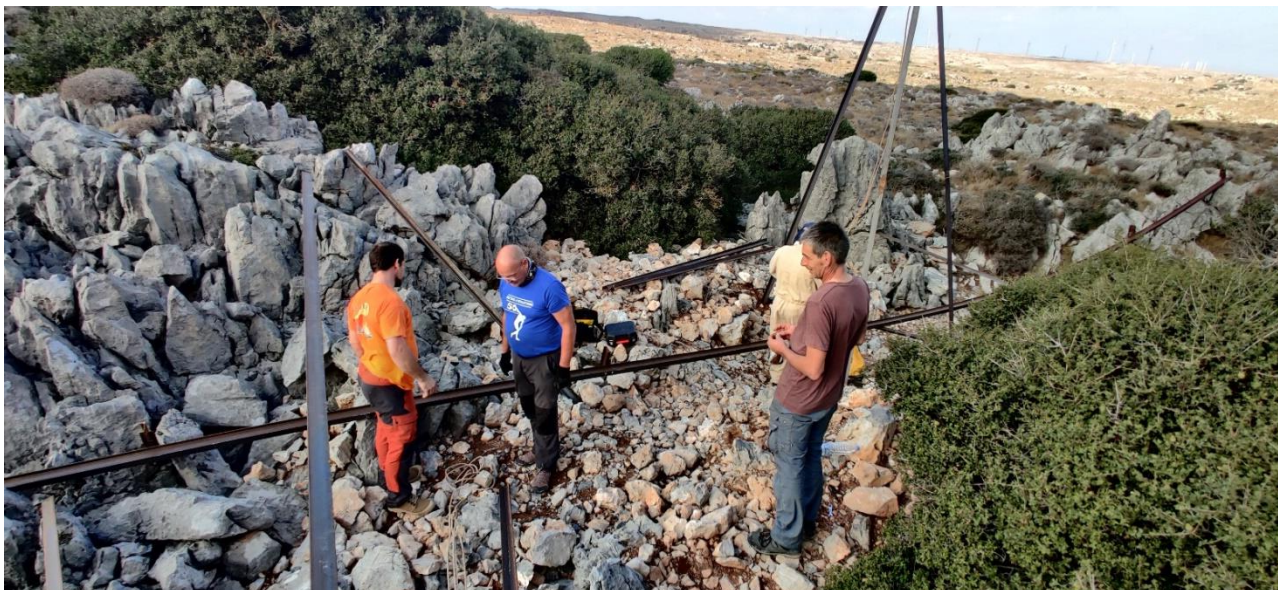
Mise en place du mono rail
